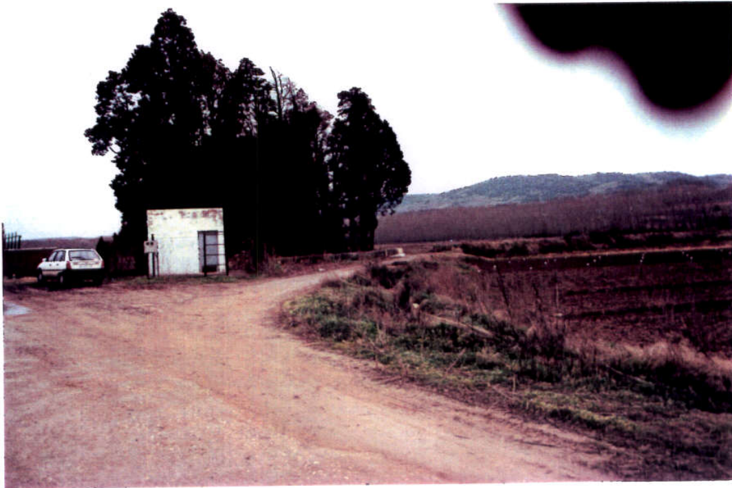
FOTO 1: Vista general del Pozo Ramiyo.
