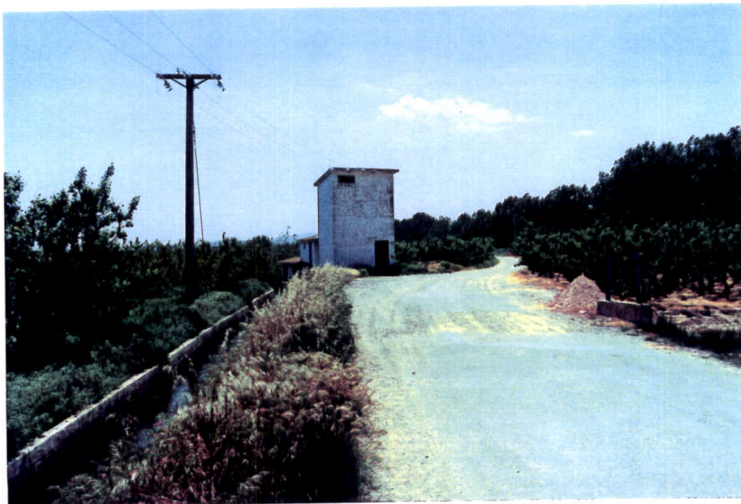
FOTO 2: Vista general del Pozo El Olivar.
